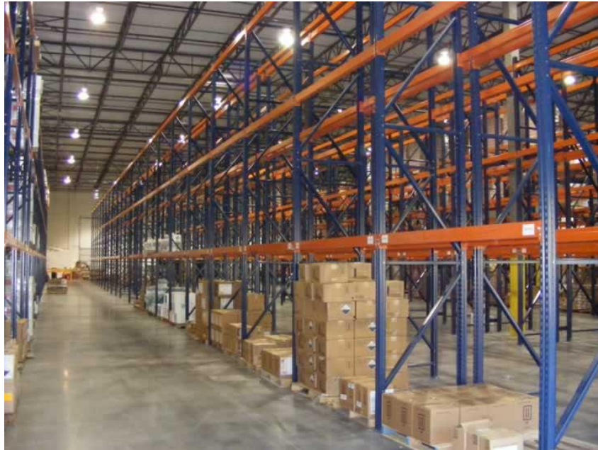
Imagen 2: Tramerías de Almacén con diseño de altura (ubicación no indicada)
