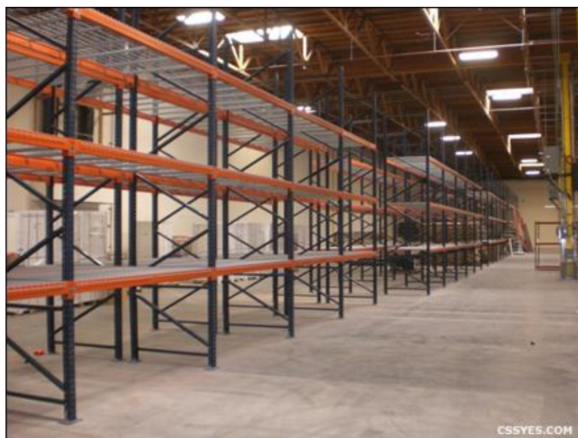
Imagen 1. Instalación de tramerías para almacén en EEUU
