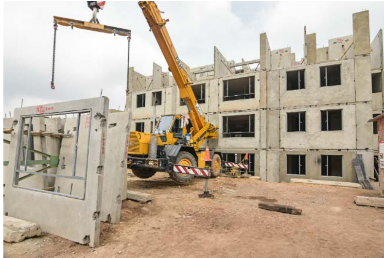
Figura 2- 8: Realización de montaje de elementos prefabricados
