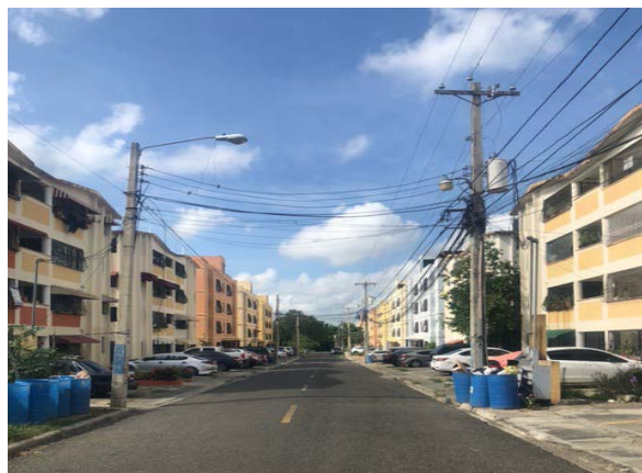
Figura 2-12: Vista general proyecto residencial Los Maestros.
